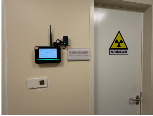
固定式剂量报警仪（PET 分装室）
