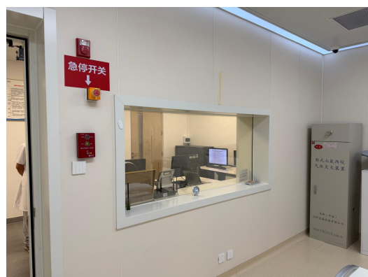
PET/CT 检查室铅玻璃窗
